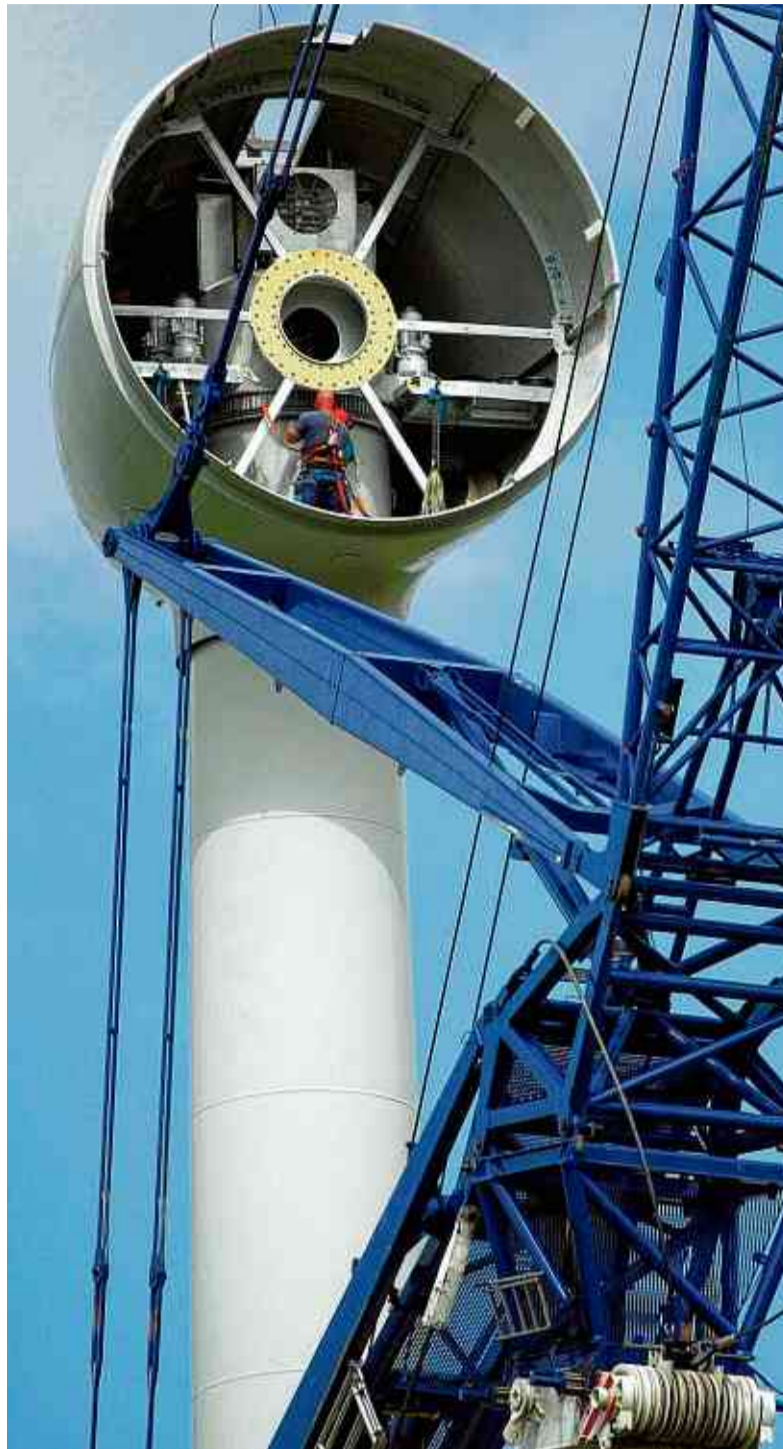
Enercon-Mitarbeiter montieren eine Windkraftanlage.
